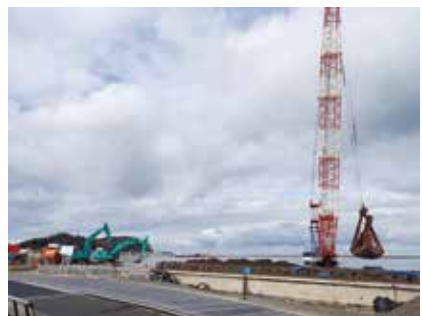
輪島港付近では再整備の工事が進む（2024年12月6日撮影）
